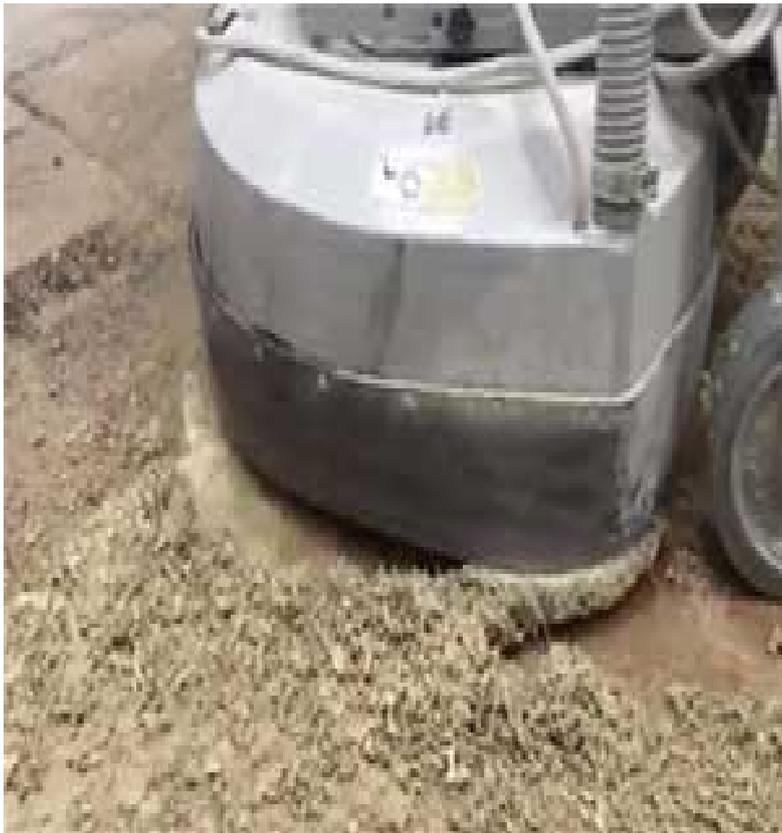
إزالة الطلاء على سطح مسابو Metal Bond Button أو Sacrificial المزودة بقضبان PCD تم تصميم أدوات للسطح المملح ولن تلحق الضرر بالخرسانة. تعمل الأضحية المضحكة أو الزر المعدني كدليل مثبت وعمق ، وتقلل من العدوانية. هذه الأدوات مناسبة لإزالة pcd قياس الأرضية الناجم عن مقاطع إلى معاجين رقيقة أو أصماغ edMedium الطلاء الايبوكسي (30 مل أو أقل) ailing
